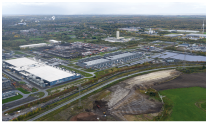
谷歌(Google)在比利时圣吉斯兰(St. Ghislain)的厂区内,部署了超大规模云服务商数据中心内首套用以替代化石燃料发电机的电池储能系统。截至2025年2月,谷歌在全球各数据中心,已部署超过1亿颗电芯组成的电池组。(图片来源:Shutterstock)
